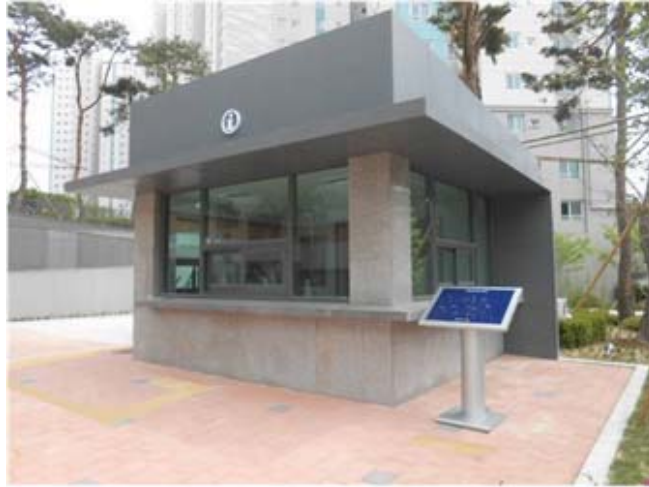
〈그림 4-42〉 경비실 점자블록, 점자안내판 설치 사례
