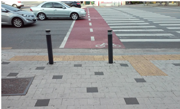
[신방화사거리] 설치위치, 폭 부적정
