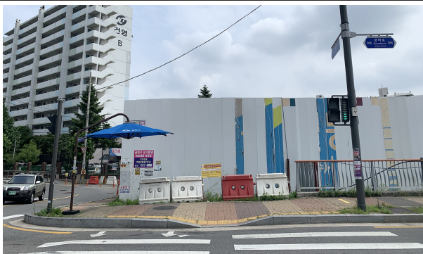
[시흥동 오피스빌딩] 선형블록 미설치
