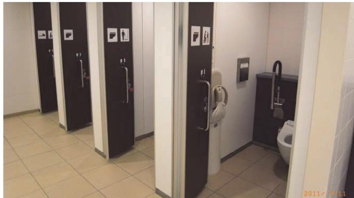
[그림 4-7] 주변 벽체와 구분되는 색상으로 설치된 대변기 출입문 사례
